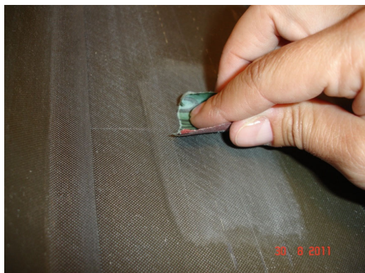
Fig. 2.2 Ponçage de la surface pour retirer la peinture ou rouille restante
