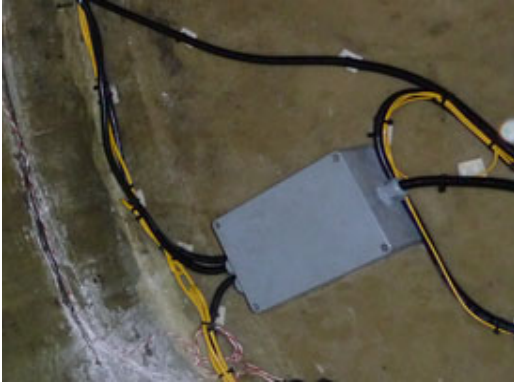
Fig. 2.11 Boîtiers de protection pour l'excédent de câble et les connexions
