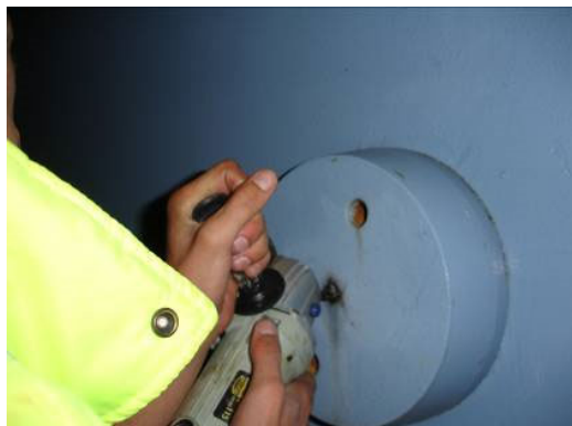
図2.1 表面のバリ取りをして、塗料や錆を除去する
