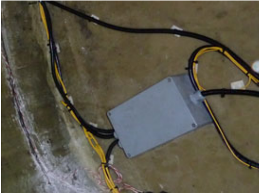
図2.11 ケーブルで余った長さの部分と端子を保護する端子箱
