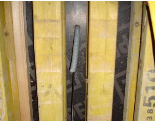
Abb. 2.4 Direkter Austritt aus der Schalung (Ansicht von außen)
