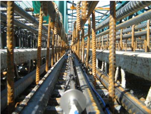
Abb. 2.10 Kabelführung
