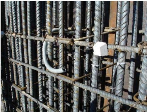
Abb. 2.1 Schutzrohr vom Kabelanschlusspunkt zur Installationsfläche des Sensors
