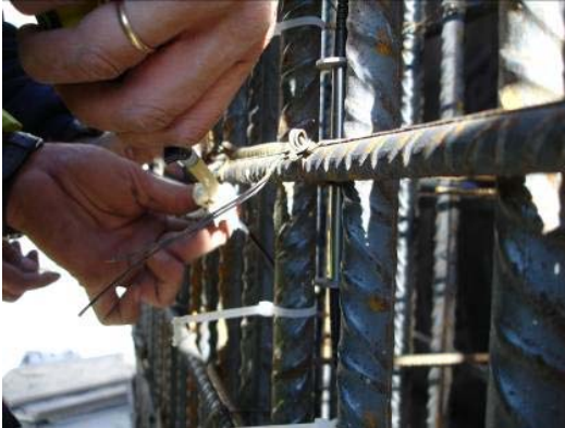
Abb. 2.12 Versiegeln des Schutzrohrs
