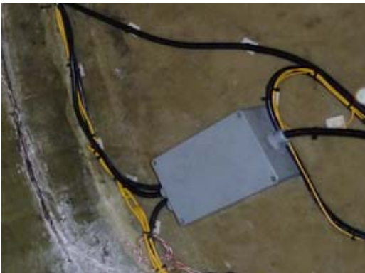
Abb. 3.13 Schutzgehäuse für nicht benötigte Kabel und Anschlüsse
