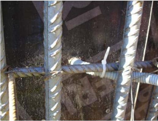
Abb. 2.3 Direkter Austritt aus der Schalung (Ansicht von innen)
