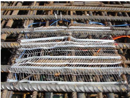
Abb. 2.14 Schutz des Sensorbereichs
