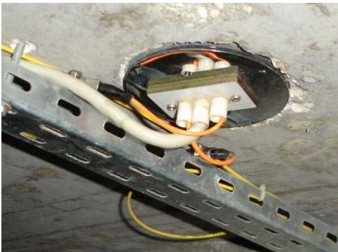
Abb. 2.6 Beispiel eines eingebetteten Schutzgehäuses
