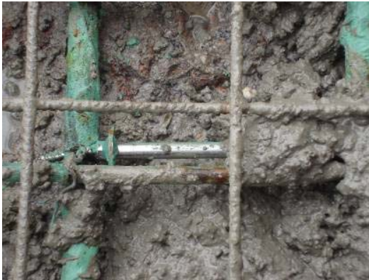
Abb. 2.13 Sensor beim Betonieren
