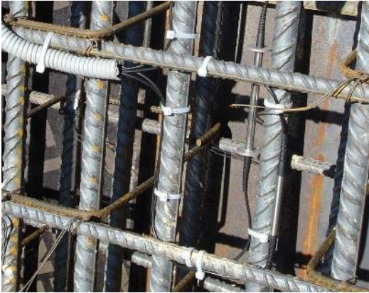
Abb. 2.11 Kabelführung
