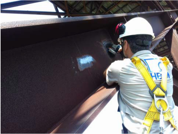
Abb. 2.1 Abschleifen der Oberfläche mit der Maschine
