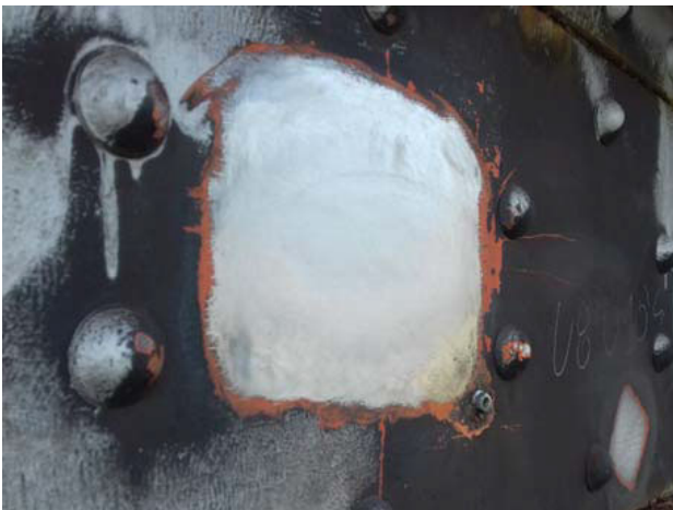
Abb. 2.4 Zum Schweißen bereite Oberfläche
