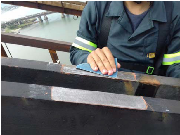
Fig. 2.3 Ponçage de la surface
