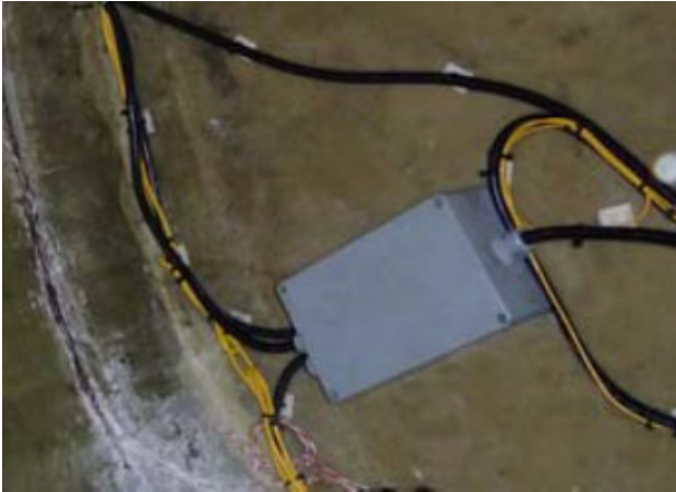
Fig. 2.31 Boîtiers de protection pour l'excédent de câble et les connexions
