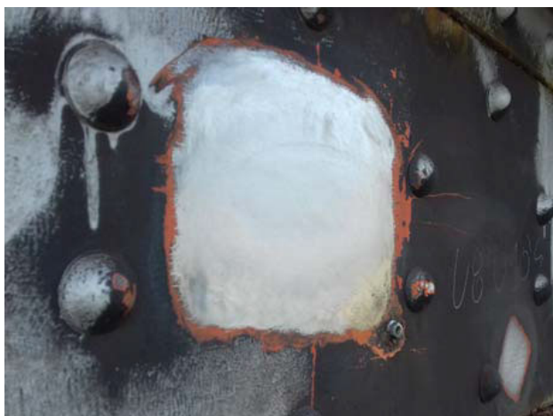
図2.4 溶接の準備ができた表面
