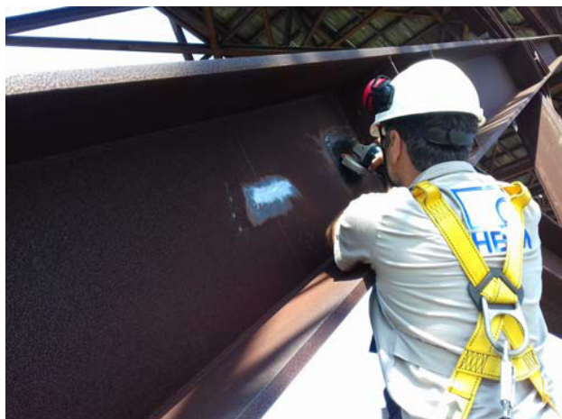
図2.1 溶接面のバリ取り
