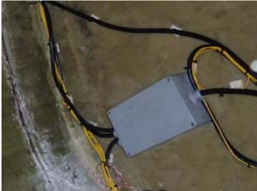
Abb. 2.4 Schutzgehäuse für nicht benötigte Kabel und Anschlüsse
