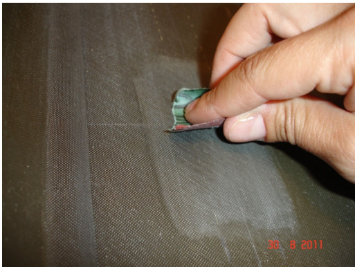
Abb. 2.2 Entfernen von Farbe und Rost mit Schleifpapier
