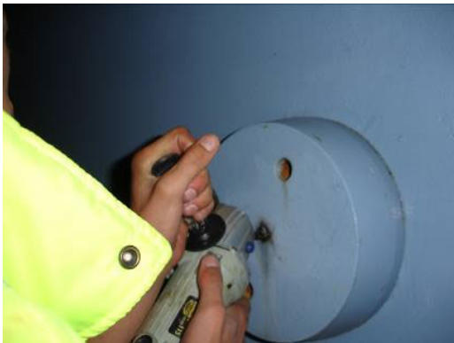
Abb. 2.1 Entfernen von Farbe und Rost mit einer Schleifmaschine
