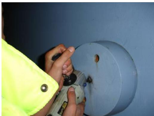
*Fig. 2.1 Enlèvement de la peinture et de la rouille avec une machine à ébavurer*
