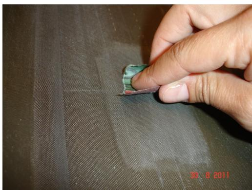
*Fig. 2.2 Enlèvement de la peinture et de la rouille avec du papier abrasif*
