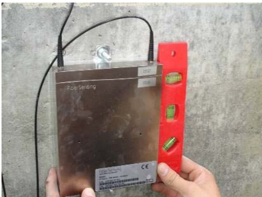
Abb. 2.6 Vertikale Ausrichtung mit einer Wasserwaage
