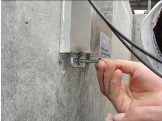
Abb. 2.5 Anbringen der Unterlegscheiben und Sechskantmuttern
