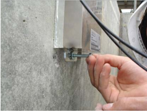
図. 2.5 ワッシャと六角ナットで固定
