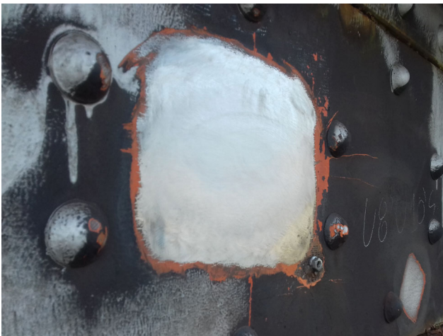
Abb. 2.4 Zum Schweißen bereite Oberfläche
