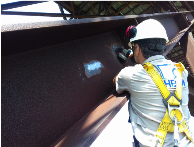
Abb. 2.1 Abschleifen der Oberfläche mit der Maschine
