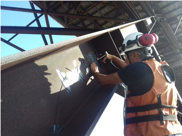
Abb. 2.17 Anschweißen des Sensors
