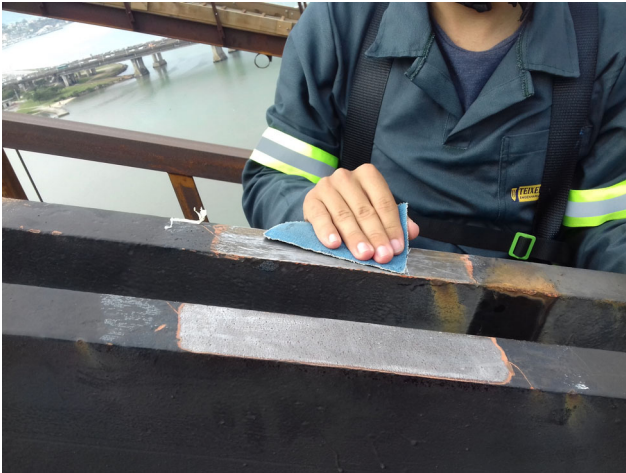
Fig. 2.3 Ponçage de la surface
