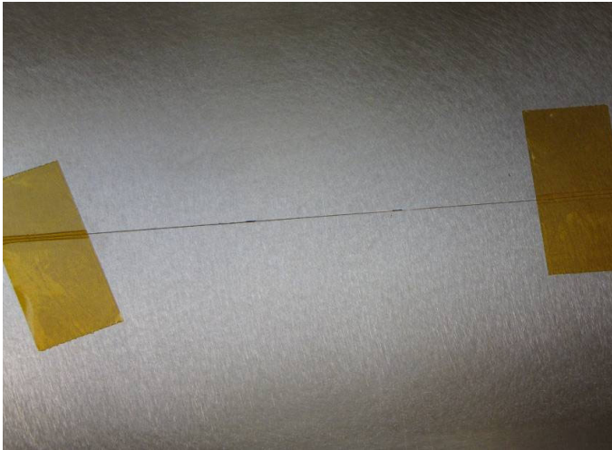
Abb. 2.8 Fixieren der Glasfaser
