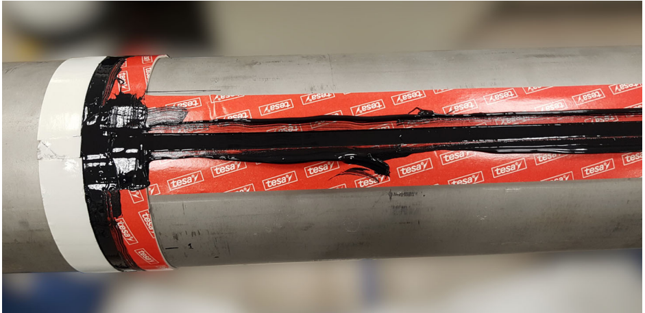
Abb. 2.21 Verteilen des Klebstoffs mit einem Spatel
