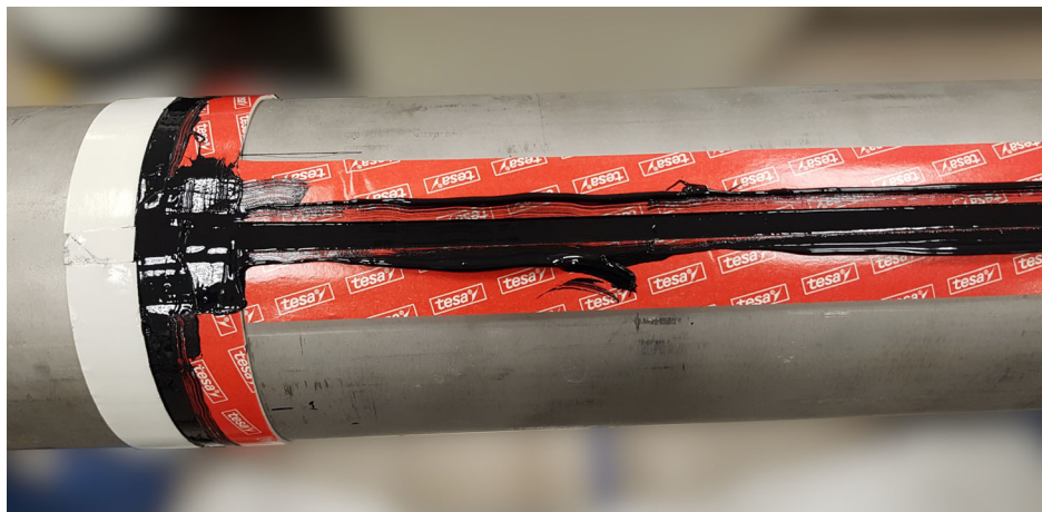
Fig. 2.21 Étalement de la colle avec une spatule
