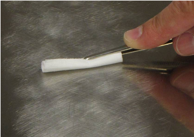
Fig. 2.4 Nettoyage de la surface d'installation poncée
