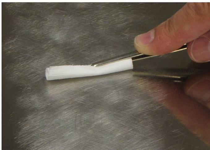
図2.4 粗面化した設置面の清掃
