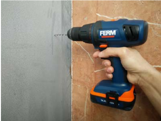
Abb. 2.4 Bohren der Befestigungslöcher
