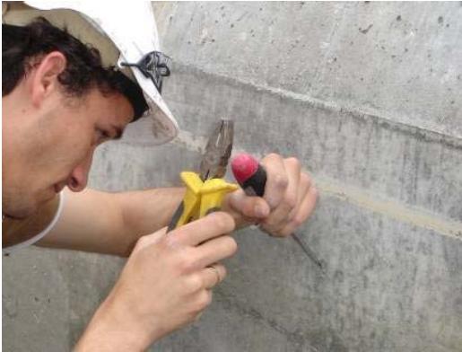
Abb. 2.1 Entfernen von Unebenheiten an der Oberfläche
