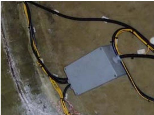
Abb. 2.9 Schutzgehäuse für nicht benötigte Kabel und Anschlüsse
