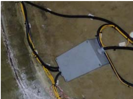
Fig. 2.9 Boîtiers de protection pour l'excédent de câble et les connexions
