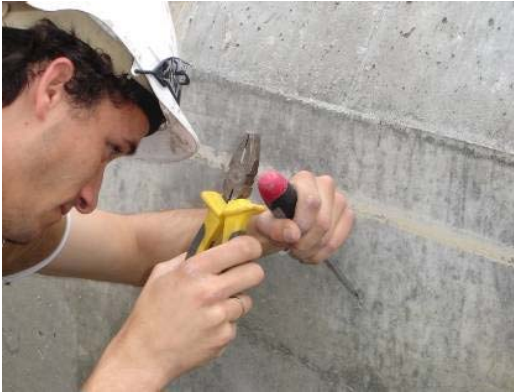
Fig. 2.1 Élimination des irrégularités de la surface
