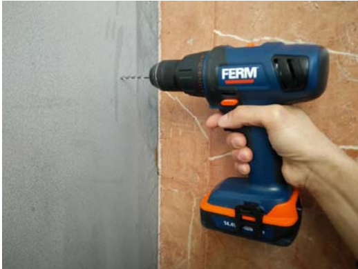
Fig. 2.4 Perçage des trous de fixation
