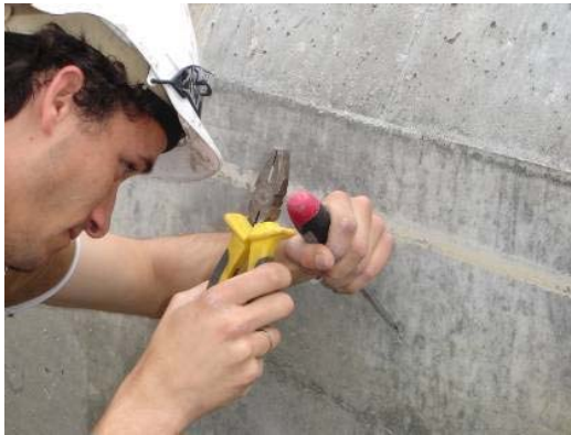
図. 2.1 表面の凹凸を取り除く
