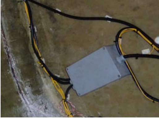
図2.26 ケーブルで余った長さの部分と接続端子を保護する端子箱
