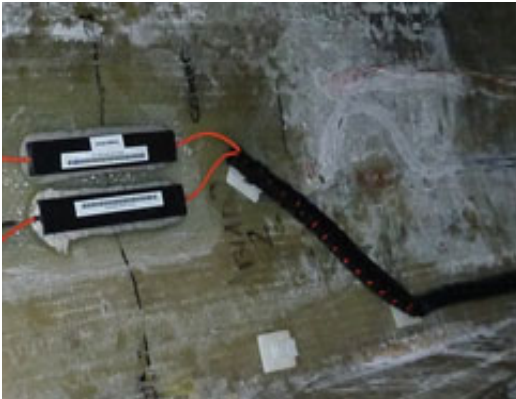
Fig. 2.3 Tubes pour la protection du câble
