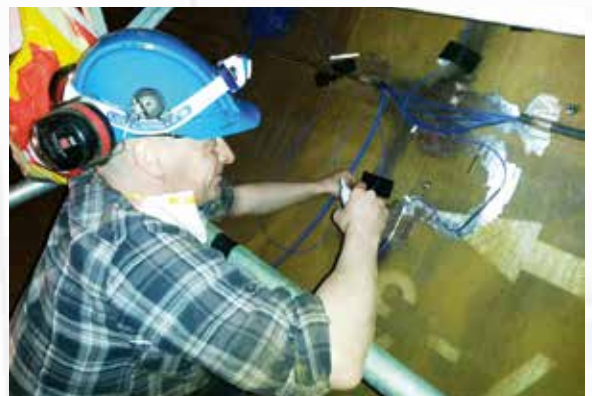
Installation optischer Dehnungssensoren an der Wasserleitung
