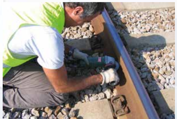
Installation von optischen Dehnungssensoren im Gleisbett
