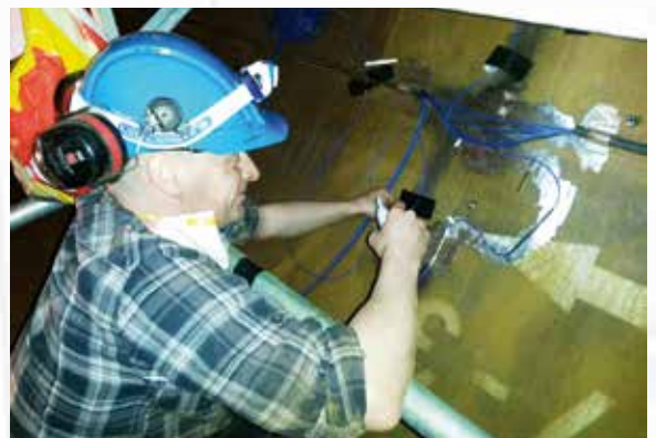
光ファイバ式ひずみセンサを導水管に設置
