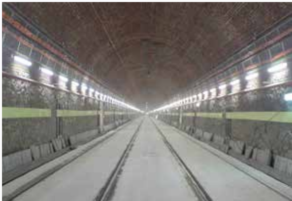
トンネルの内壁に沿ってセンサを設置
