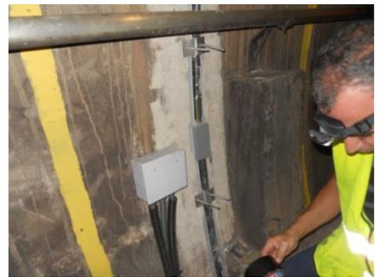
Fig. 54: Optical cable box
