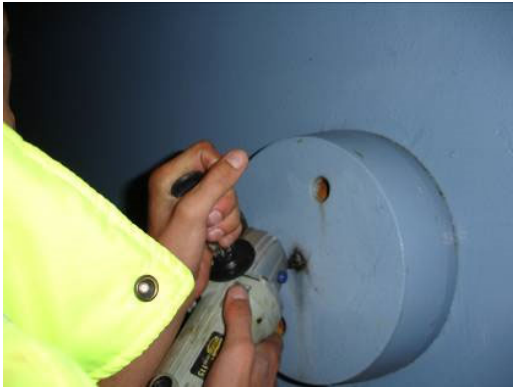
Abb. 2.1 Entfernen von Farbe oder Rost durch Abschleifen mit der Maschine
