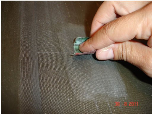
Abb. 2.2 Entfernen von Farbresten oder verbliebenen Rostspuren durch Nachschleifen von Hand
