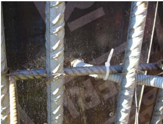
Fig. 2.3 Sortie directe du coffrage (vue intérieure)
