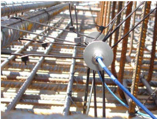
Fig. 2.8 Positionnement du capteur
