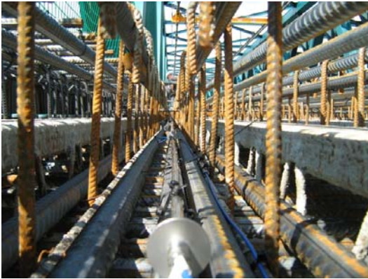
Fig. 2.10 Pose des câbles
