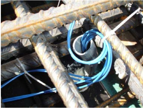
Fig. 2.2 Détails de la pose des câbles
