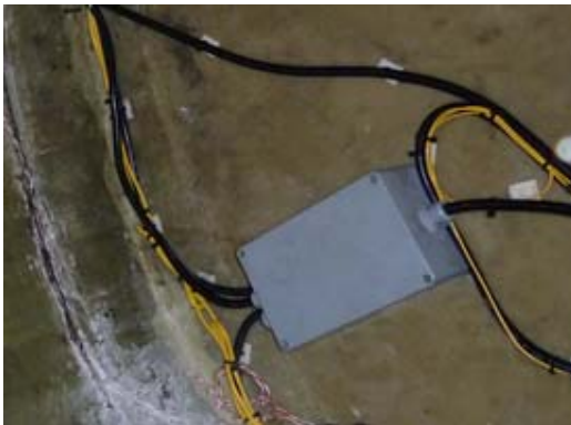
Fig. 3.13 Boîtiers de protection pour l'excédent de câble et les connexions
