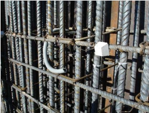
Fig. 2.1 Tube de protection allant du point de collecte des câbles jusqu'à la surface d'installation du capteur
