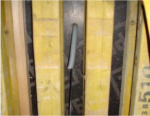
Fig. 2.4 Sortie directe du coffrage (vue extérieure)
