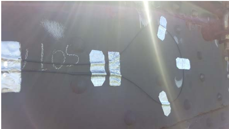
Fig. 3.11 Pose des câbles
