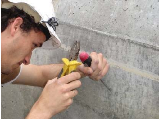
Fig. 3.1 Élimination des irrégularités de la surface
