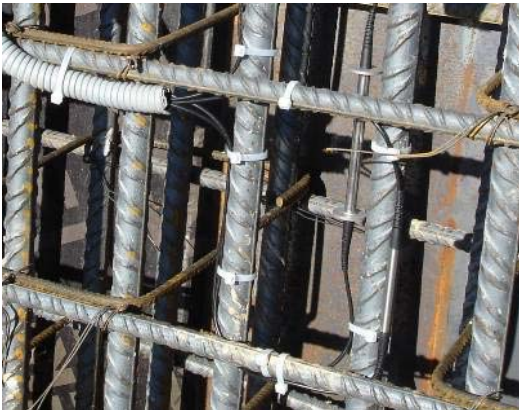
Fig. 2.11 Pose des câbles
