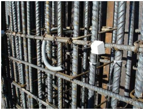
図. 2.1 ケーブル集合ポイントからセンサ設置エリアまでの保護チューブ
