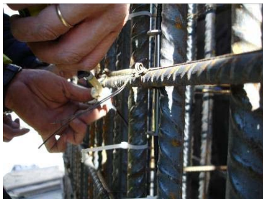
図. 2.12 保護チューブのシーリング
