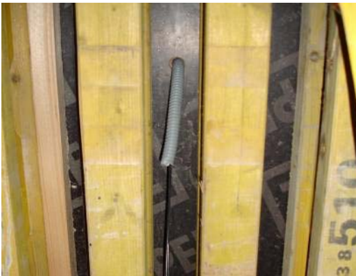
図. 2.4 型枠から直接、保護チューブを出す (型枠の外側)
