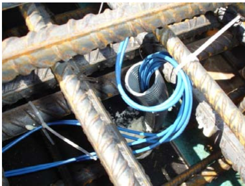
図. 2.2 ケーブル敷設部分の細部
