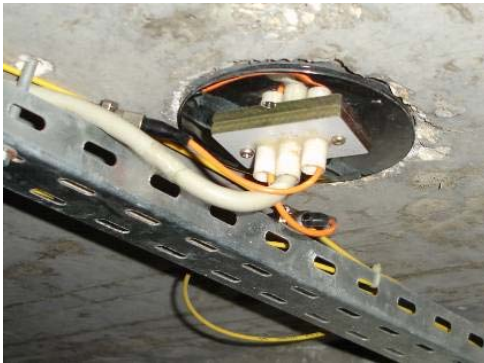
図. 2.6 埋込型の保護ボックスの例
