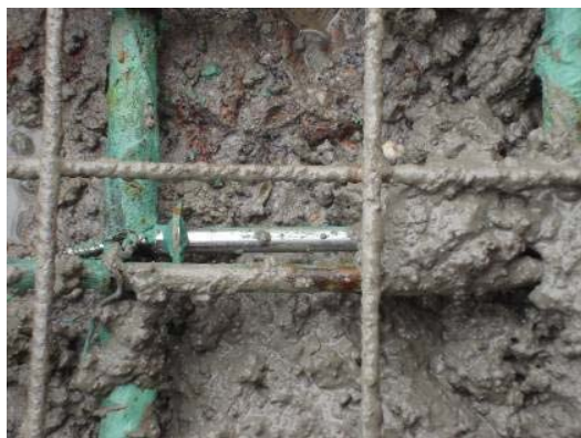
図. 2.13 生コンクリート投入時のセンサ
