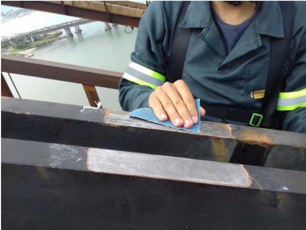
Abb. 2.4 Nachschleifen der Oberfläche von Hand
