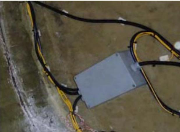
Abb. 2.37 Schutzgehäuse für nicht benötigte Kabel und Anschlüsse
