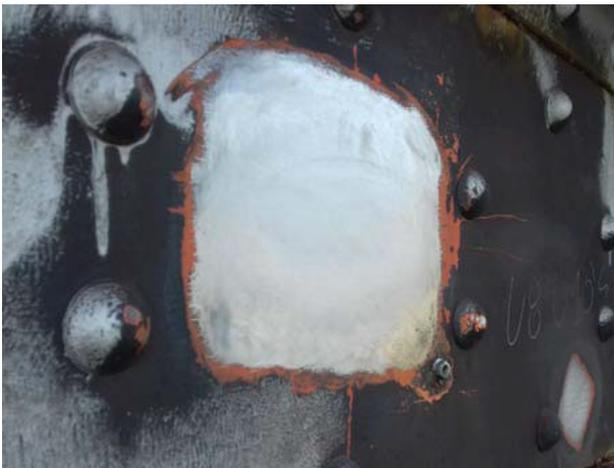
Abb. 2.5 Zum Schweißen bereite Oberfläche
