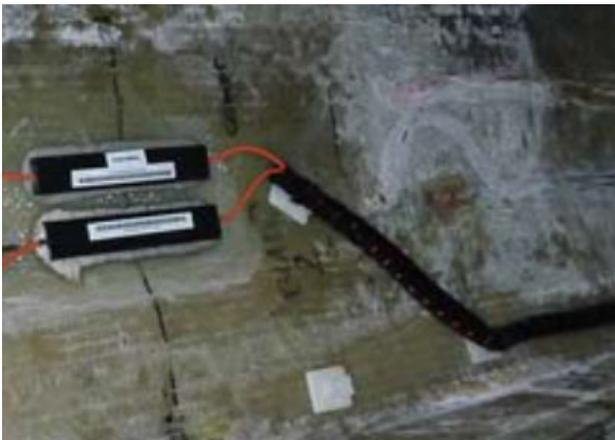
Abb. 2.36 Mit Wellrohren geschütztes Kabel
