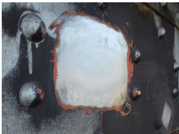
Fig. 2.5 Surface prête pour le soudage
