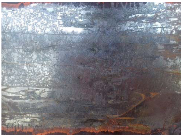
Fig. 2.3 Surface non plane et rouillée ne permettant pas le soudage du capteur
