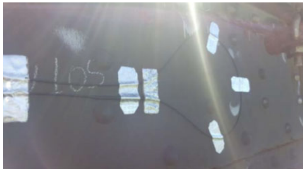
Fig. 2.35 Pose des câbles
