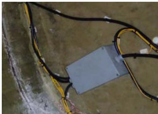
Fig. 2.37 Boîtiers de protection pour l'excédent de câble et les connexions
