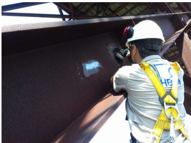
図2.2 溶接面のバリ取り
