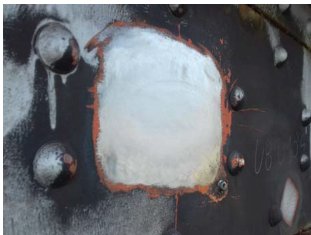
図2.5 溶接の準備ができた表面
