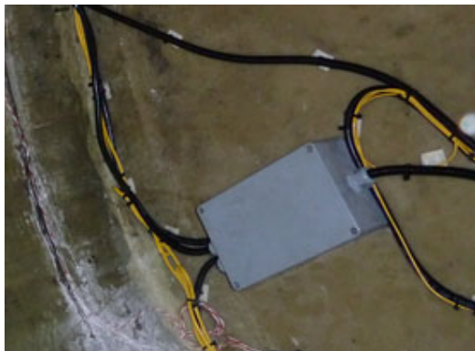
Fig. 2.4 Boîtiers de protection pour l'excédent de câble et les connexions
