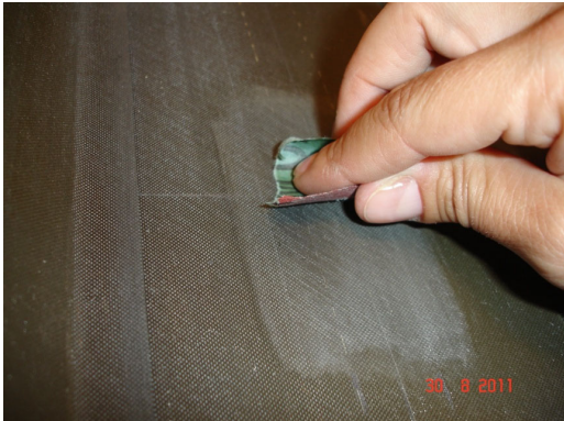
Abb. 2.3 Entfernen von Farbe und Rost mit Schleifpapier
