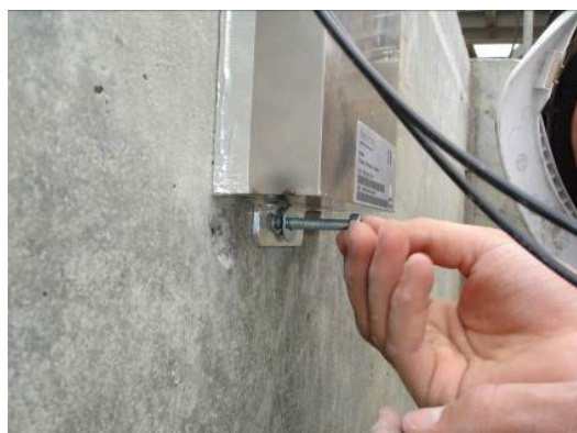
図2.5 ワッシャと六角ナットで固定
