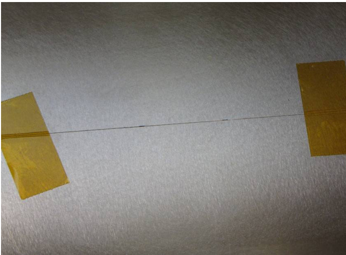
Abb. 2.8 Fixieren der Glasfaser
