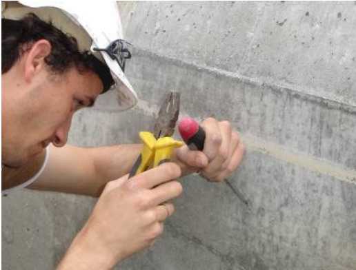
Abb. 2.1 Entfernen von Unebenheiten an der Oberfläche
