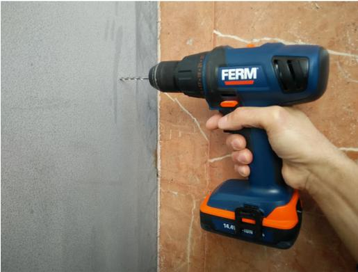
Fig. 2.4 Perçage des trous de fixation
