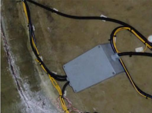
Abb. 2.26 Schutzgehäuse für nicht benötigte Kabel und Anschlüsse
