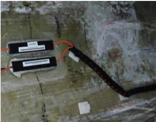
Abb. 2.25 Mit Wellrohren geschütztes Kabel
