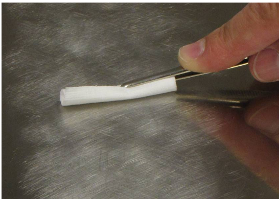
図2.4 粗面化した設置面の清掃
