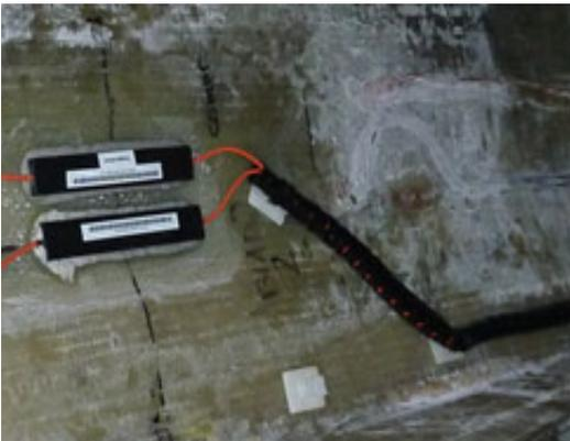
Abb. 2.7 Mit Wellrohren geschütztes Kabel
