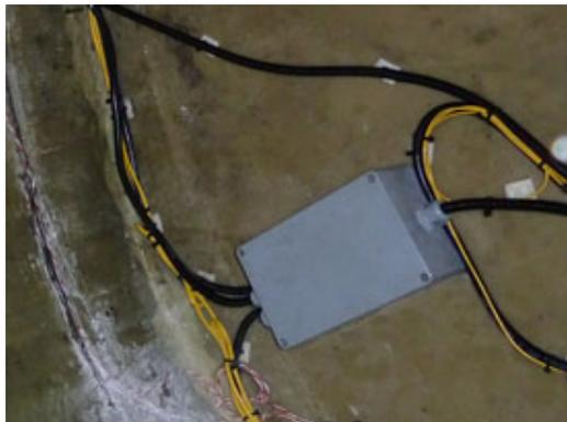
Abb. 2.8 Schutzgehäuse für nicht benötigte Kabel und Anschlüsse
