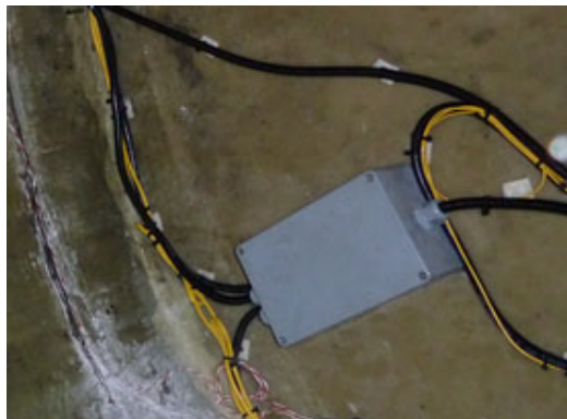
Fig. 2.8 Boîtiers de protection pour l'excédent de câble et les connexions
