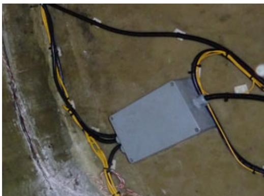
図2.8 ケーブル配線で余った長さ部分と接続端子を保護する端子箱
