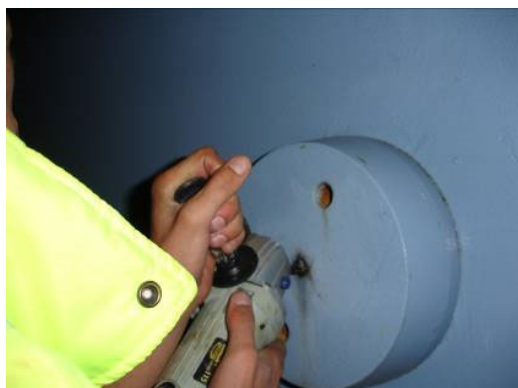
図2.1 バリ取り機を使用して塗装と錆を取り除きます
