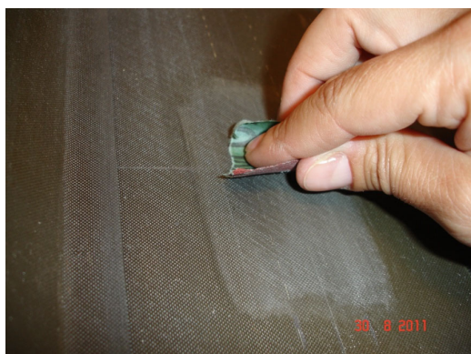
図2.2 紙やすりを使用して塗装と錆を取り除きます
