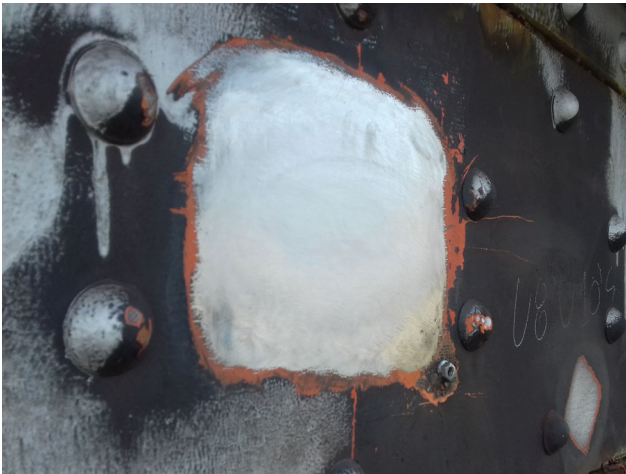
図2.4 溶接の準備ができた表面
