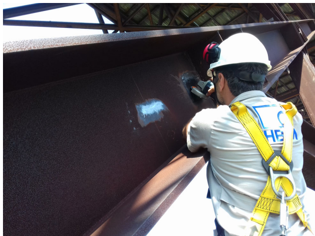
図2.1 溶接面のバリ取り
